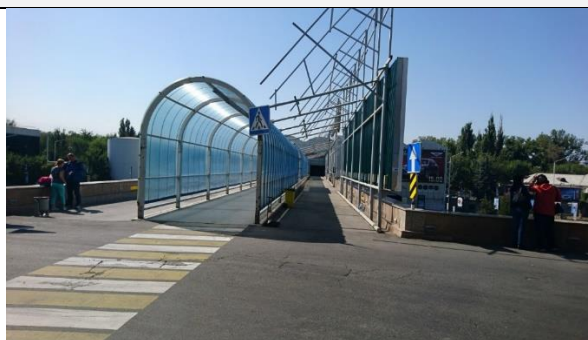
Переход на крытую парковку перед основным зданием аэропорта
