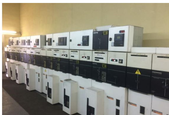
Снимок: Главная подстанция
