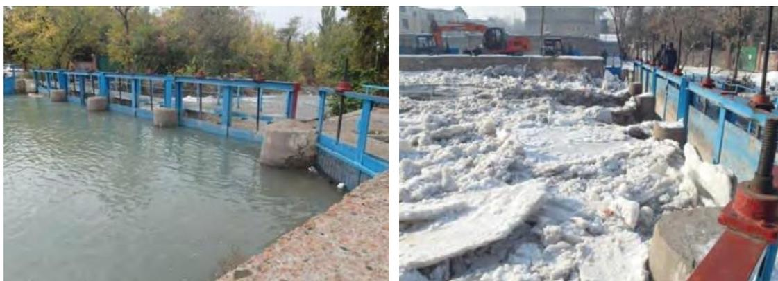
Рисунок 5. Резерв летом (слева) и ледовый затор (шуга) зимой (справа) на гидрораспределителе на реке Ала-Арча (ул. Скрябина). Источник: Ежегодный каталог, Министерство чрезвычайных ситуаций. Глава 10. Г. Бишкек.
