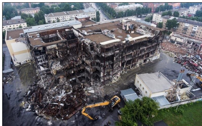
Рисунок 2 – Пожар в торговом центре «Зимняя вишня» г. Кемерово
