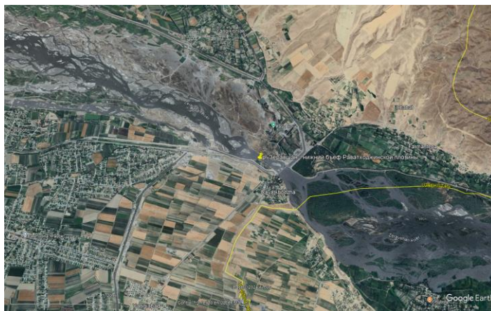
Рис. 2.7.1. Расположение гидропоста р. Зеравшан - нижний бьеф Раватходжинской плотины
